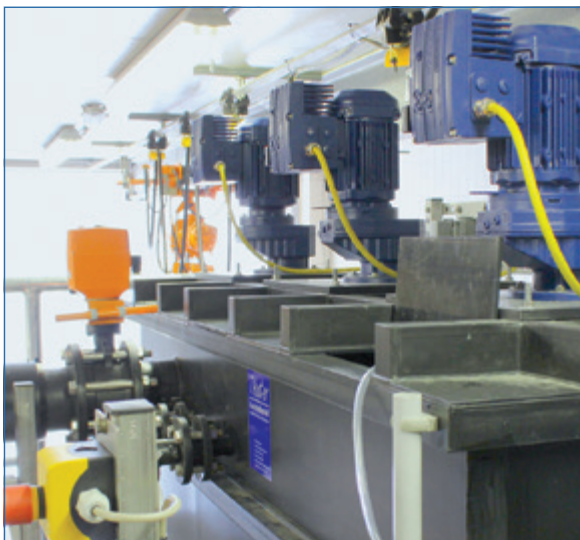
Abb. 8: Mehrstufige Mischkaskade der Pilotanlage
